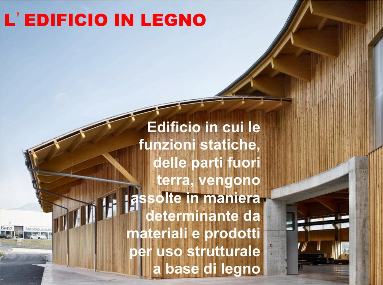
Edificio in cui le funzioni statiche, delle parti fuori terra, vengono assolte in maniera determinante da materiali e prodotti per uso strutturale a base di legno
